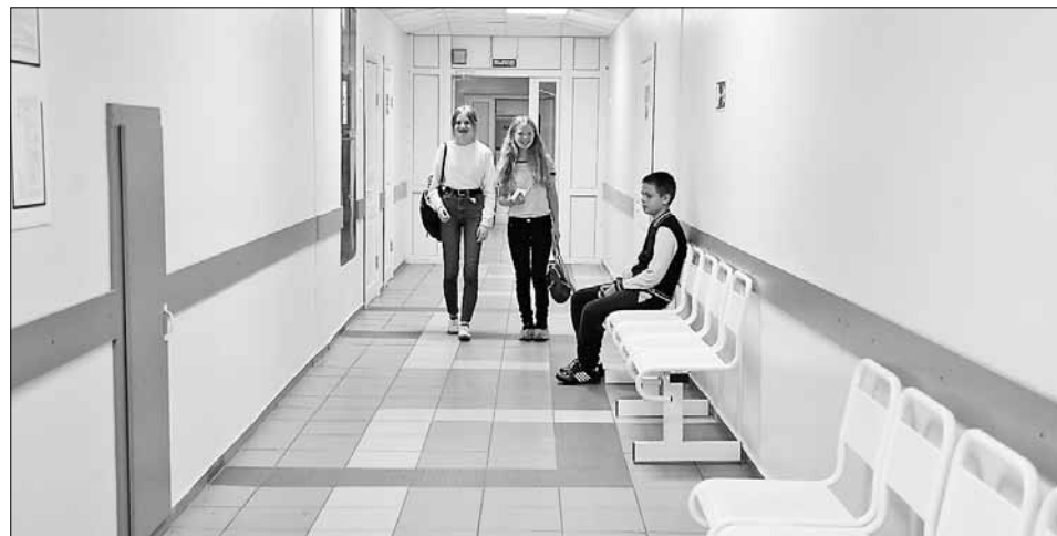
■ Отремонтированные коридоры в здании стационара
